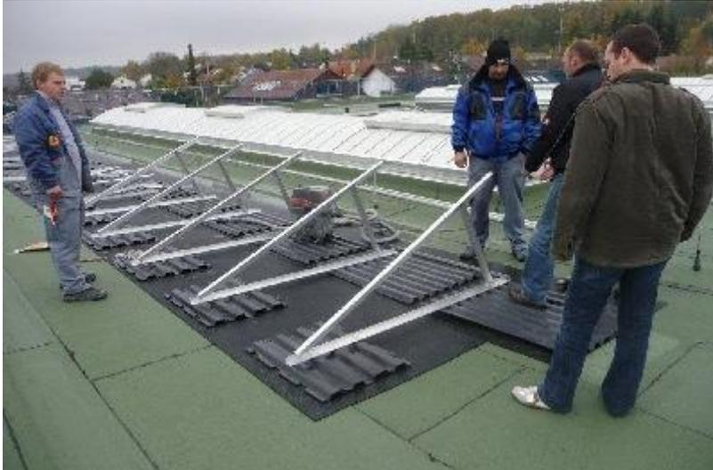
**25.10.2010:** Die ersten Gestelle wurden aufgestellt. Insgesamt müssen die 8 Reihen mit Alu-Profilen mit über 2000 Nieten an den gewellten Kunststoffbodenplatten befestigt werden.
