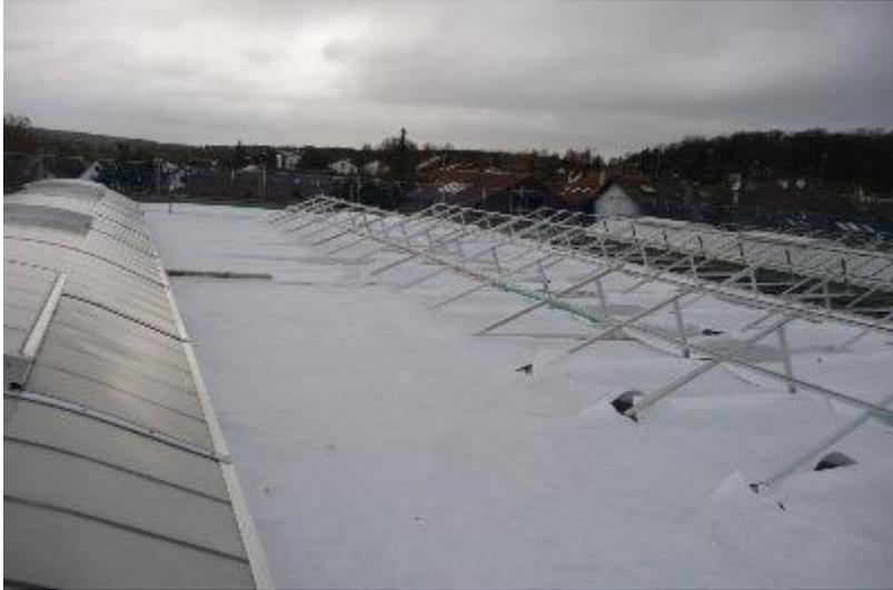
**10.11.2010:** Heute wurde das Vlies, das unter das Granulat kommen soll, ausgelegt. Ab morgen soll das Granulat für die Dachbegrünung aufgebracht werden. Nächste Woche werden voraussichtlich die Module montiert.
