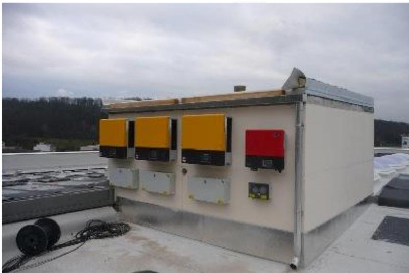
**23.11.2010:** Unter den Wechselrichtern wurden die Überspannungsschutz-Kästen angebracht und die Verkabelung weiter geführt.
