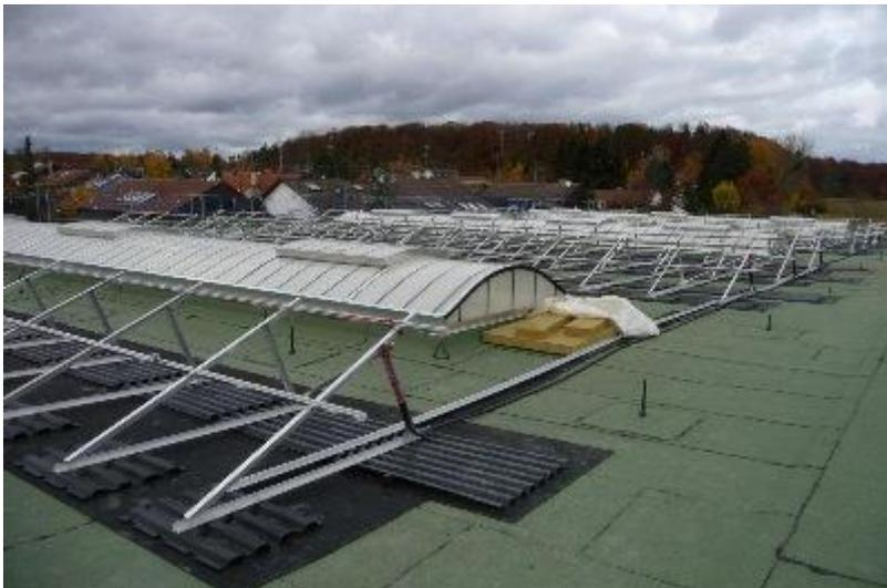
**4.11.2010:** Die Gestelle und die Kabel sind fertig montiert. Die einzelnen Module werden zur Erhöhung der Stabilität mit Aluprofilen untereinander verbunden. Die Solarkabel sind in schwarze Kunststoffrohre gebündelt und nach unten über einen sog. Schwanenhals (damit kein Wasser eindringen kann) durch das Dach zu den Wechselrichtern geführt.
