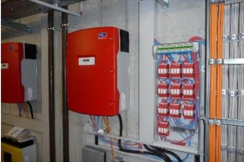
**28.1.2011:** Hier sieht man neben den inzwischen mit einem roten Deckel versehenen Wechselrichtern rechts daneben den aufwendigen Überspannungsschutz für den Fall, dass doch einmal der Blitz einschlägt.
