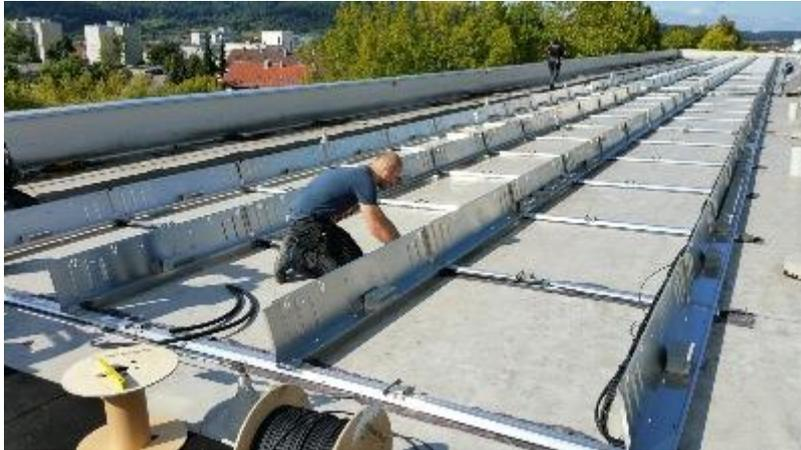
5.9.15 Verlegung der Solarkabel, Modulgestelle fertig montiert, Betonsteine zur Beschwerung angebracht
