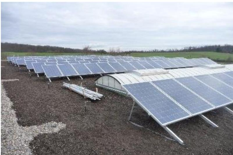
**19.11.2010:** Fertig montierte Module auf dem Dach der Mehrzweckhalle in Gebersheim. Wir warten nur noch auf den Stromverteiler im Untergeschoss. Die Toleranz der Module liegen alle im Plusbereich, so dass wir sogar um ein Modul höhere Leistung installiert haben. Statt 34,2 kWp sind es 34,4 kWp.
