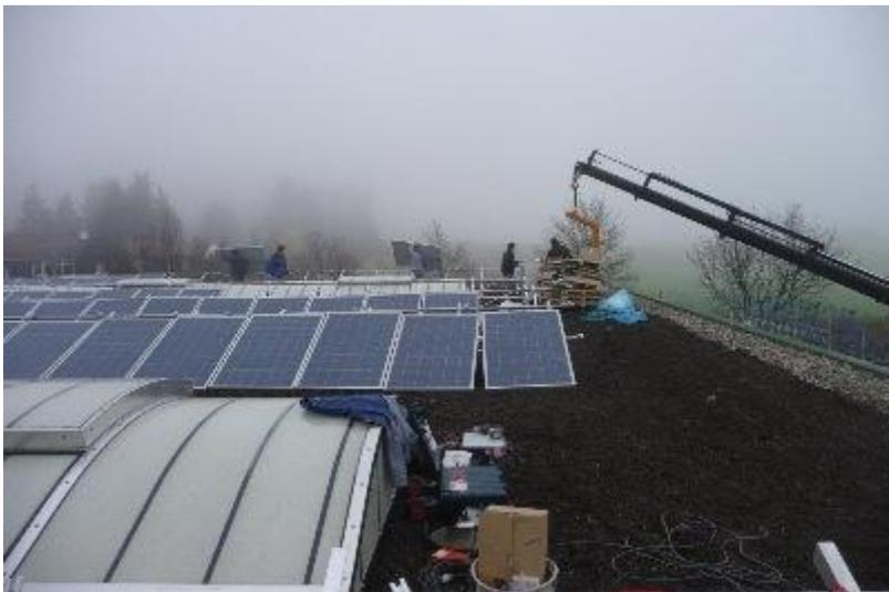
**18.11.2010:** Bei nebligem, kaltem Wetter werden die 152 Module angeliefert und auf dem Dach auf die Gestelle verteilt.
