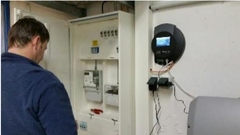
Zählermontage durch Monteur der Netze BW, rechts Solarlog zur Datenübertragung ins Internet.
