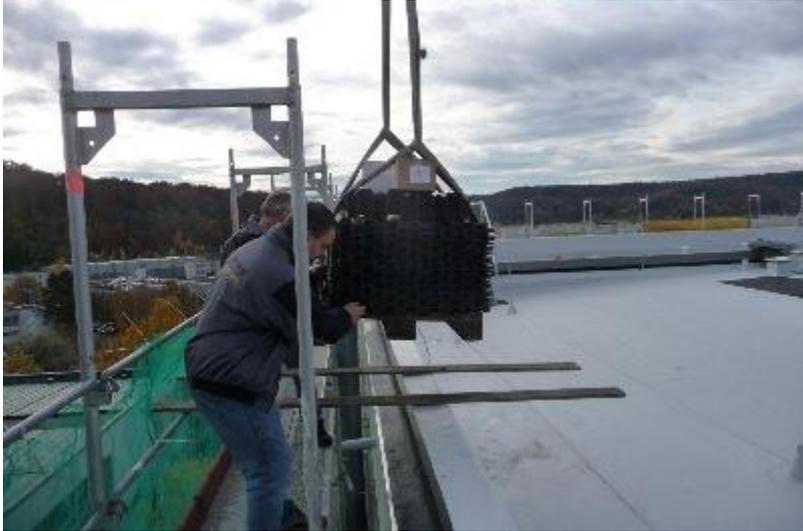
**3.11.2010:** Die ersten Paletten mit Kunststoffmatten werden mit dem Kran aufs Dach gebracht. Mit der Montage kann begonnen werden...
