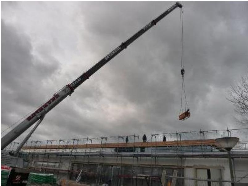
**11.11.2010:** Einbringen des Substrats für die Dachbegrünung mit dem Autokran und einer Schütte. Der Autokran musste infolge des Sturms und böiger Winde mehrmals seinen Einsatz unterbrechen..
