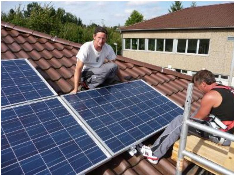
Am 2.9.08 um 16.02 Uhr wurde das letzte der 224 Solarmodule installiert. Ein Modul hat eine Fläche von ca. 1,5 qm und wiegt rund 20 kg.
