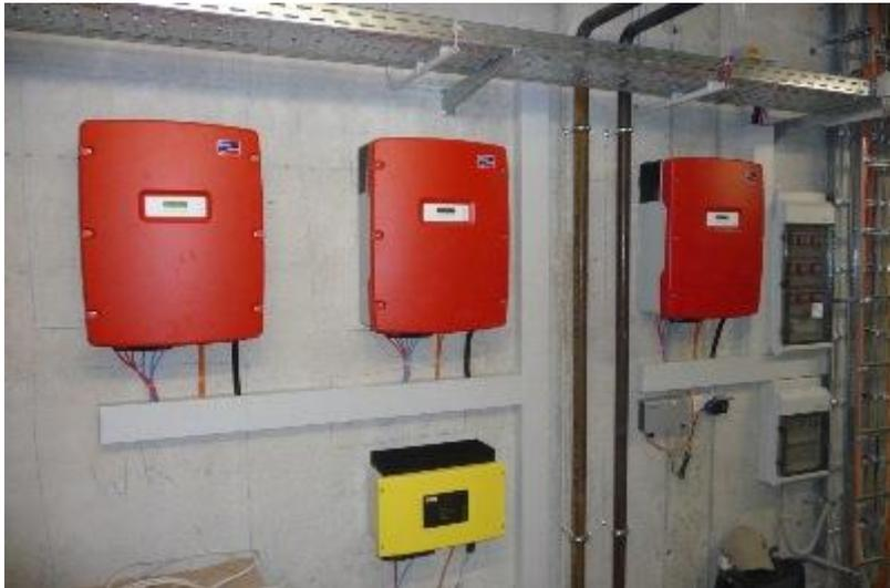
**2.2.11:** Die 4 Wechselrichter (rot und gelb) sowie daneben die Webbox zur Datenerfassung (grauer Kasten rechts neben dem gelben Wechselrichter). Alle Wechselrichter sind in Betrieb und speisen in das Stromnetz ein.
