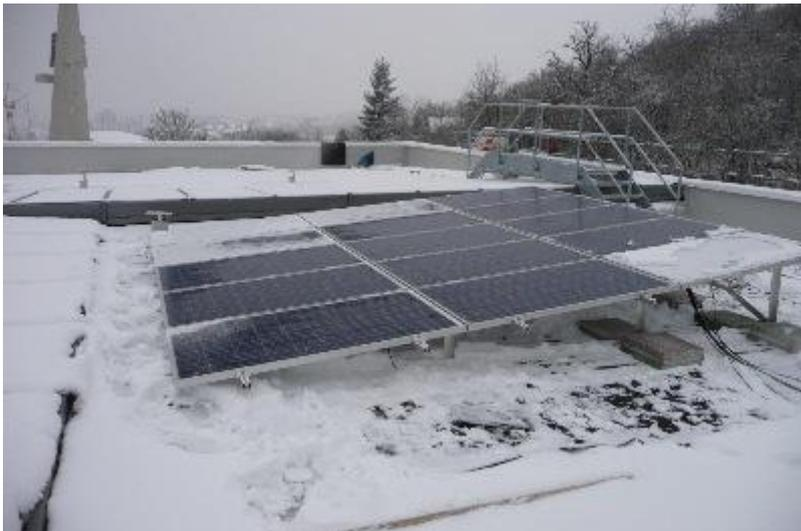
**29.11.2010:** unter äußerst widrigen Verhältnissen wurden auf dem Norddach heute Morgen 15 aufgeständerte Module montiert. Am Nachmittag wurde bei erneutem Schneefall mit dem Autokran die restlichen 90 Module aufs Dach gebracht.
