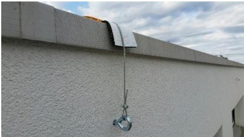
Verankerung der Modulgestelle mit Stahlseilen damit wird ein Abrutschen verhindert.
